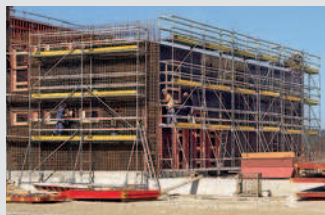
Állványok betonacél szereléshez
